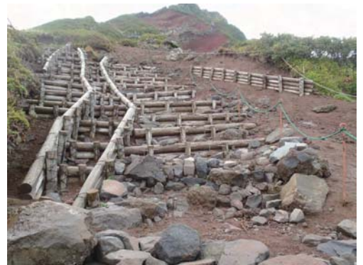
写真3. 鴛泊登山道標高1410m付近（9合目直下）の木柵階段と土留工事
