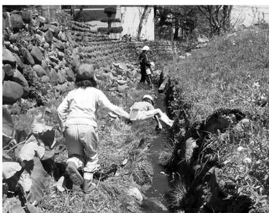
下流ではすでに整備が終了しているが、巨大な岩のような石をつかった護岸をしており、住民からは過剰な護岸と景観にあわないことで評判は芳しくない。西野川周辺は水が浸透しやすいシキ質の基質で、大雨が降っても地形的に一カ所に集まりにくい。大雨時でも想定するほど川の水量が増えると考える人は地元でも少なそうだが、護岸の基準が全国一律に設けられていることで、過剰に見える護岸が作られてしまうのだろう。水は無いけど治水強化の矛盾はしばしば育てる会でも話題に挙がっている…。
