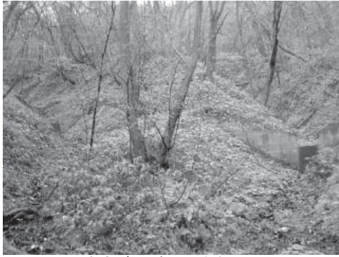
砂防ダムが設置された沢
